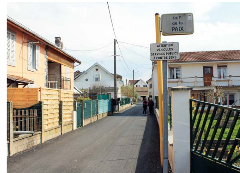
Réfection de la rue de la Paix réalisée en 2018
