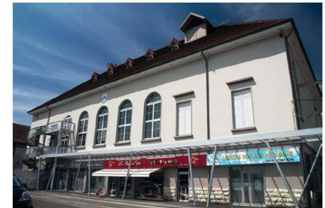
Cellules commerciales sous le Foyer Municipal
