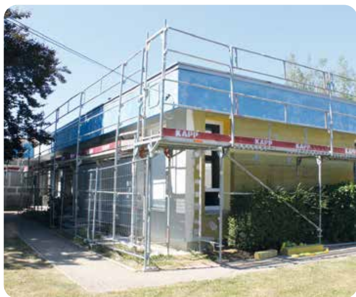
Travaux école G. Edme
