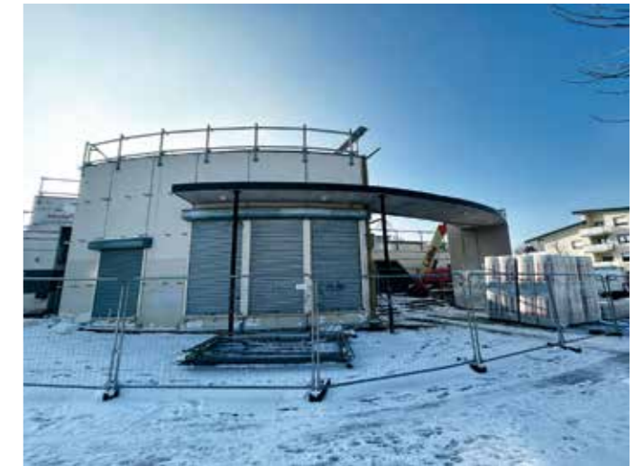
Les travaux de rénovation de la MJC Saint-Exupéry ont débuté.
