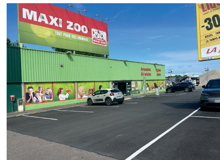
Exemple de façade à rénover: Maxi Zoo
